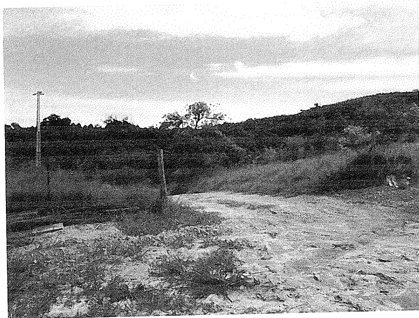
Figura 3 - Acesso ao espaço de uso comum (Estrada de chão e em vias de conclusão)
